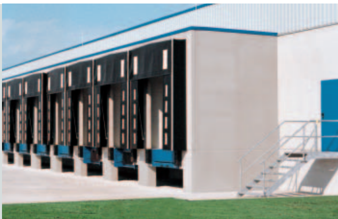
Elő-zsilipek készbeton elemekből
